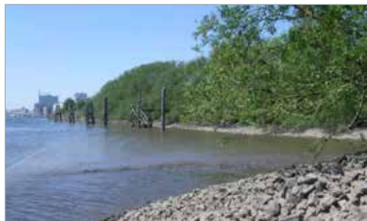
Abb. 27 | Prager Ufer, Schüttsteinböschung mit Weidengehölzsaum
