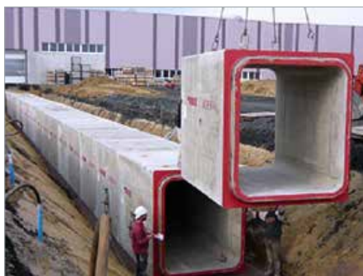
Abb. 7 | Beispiel für einen Medienkanal (im Bau)
