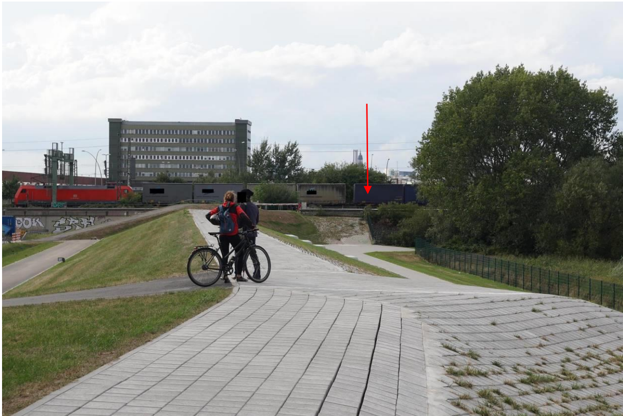
Abb. 83: Öffentliche Hochwasserschutzanlage Ausschnitt (Deichabschnitt Nördliche Veddel), möglicher Anschlusspunkt für Elbsteg Ostseite (roter Pfeil) (Quelle: Thomas Hampel im Auftrag der HafenCity Hamburg GmbH (HCH), 2019; zusätzlich eigene Darstellung, Angaben gemäß HafenCity Hamburg GmbH (HCH); zusätzlich anonymisiert)
