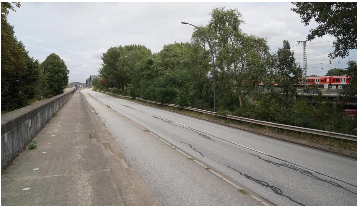
Abb. 79: Straße Am Moldauhafen bis Freihafenelbbrücke, Ausschnitt (Quelle: Thomas Hampel im Auftrag der HafenCity Hamburg GmbH (HCH), 2019)
