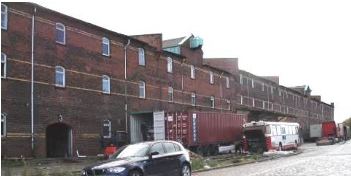
Abb. 135: Lagerhaus G an der Dessauer Straße, Blickrichtung Südost (Quelle: Elbberg Stadtplanung)
