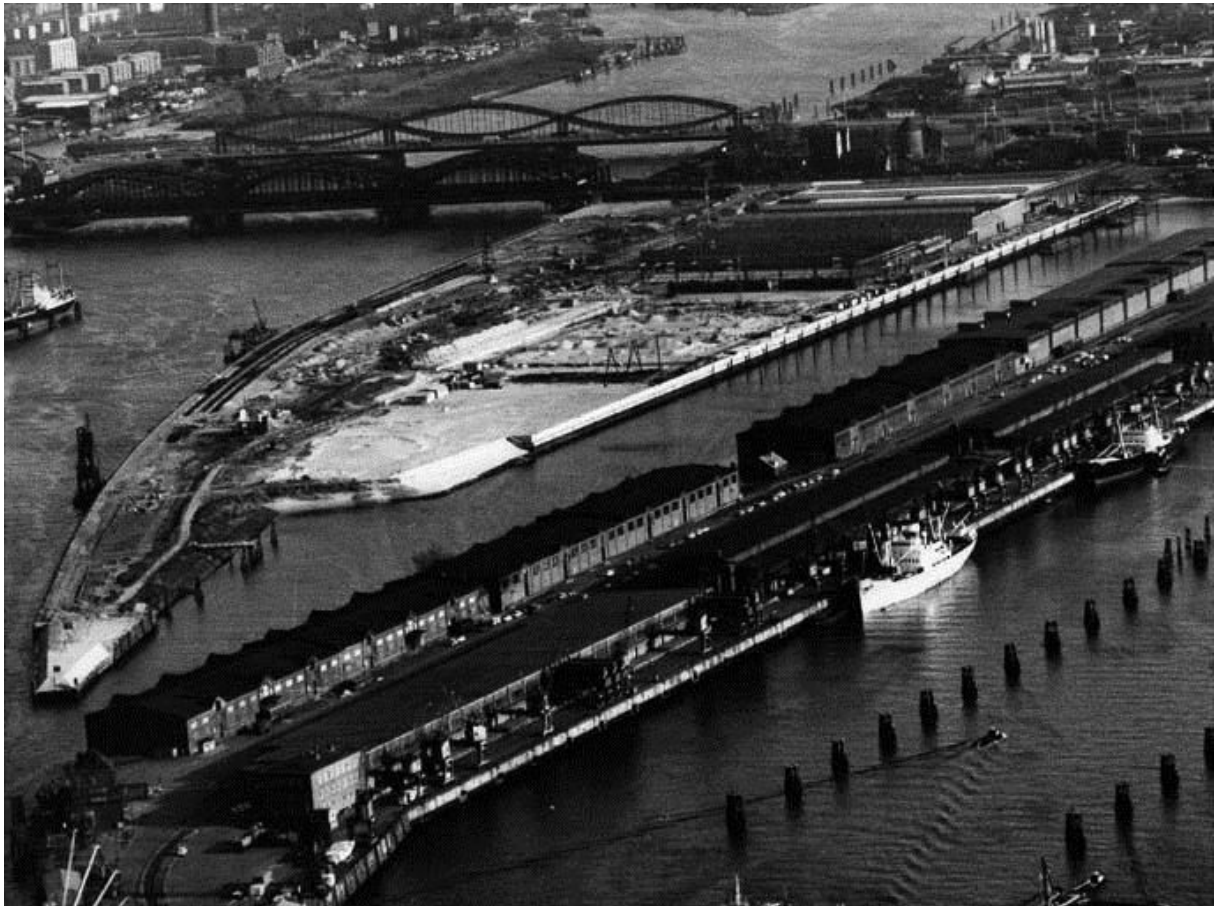
Abb. 20: Überseezentrum im Bau 1964, Ausschnitt (Quelle: O+P Geotechnik GmbH; Hamburg Port Authority AÖR (HPA))
