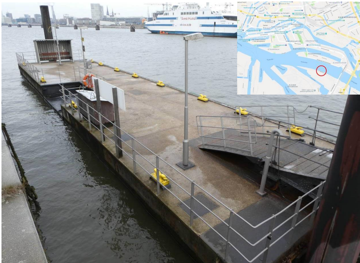
Abb. 84: Ponton Grasbrook, aktueller Zustand 2019 und Lageplan, Ausschnitt (Quelle: Ingenieurbüro Dr. Binnewies Ingenieurgesellschaft mbH, 05. 03. 2019)
