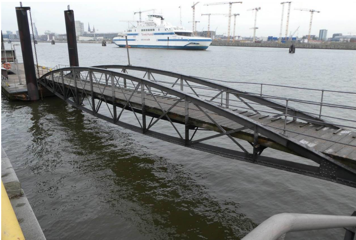
Abb. 85: Brücke, aktueller Zustand 2019, Ausschnitt (Quelle: Ingenieurbüro Dr. Binnewies Ingenieurgesellschaft mbH, 05. 03. 2019)
